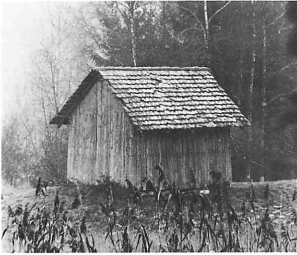
«Hotel» für heimatlose Strolche und Vaganten: Turpenhütte im Laufenried
