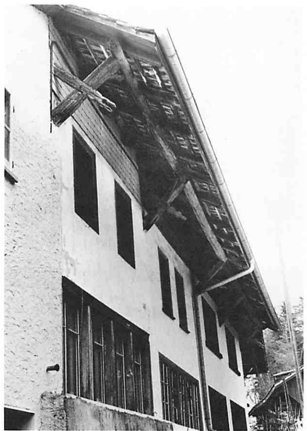
Vordachkonstruktion mit Tierköpfen in Rüeggshusen
