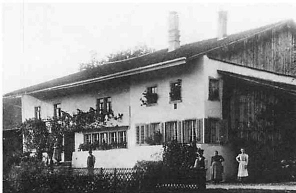
Das alte Laufenriet-Haus vor der Hebung des Daches
