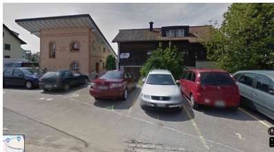
Gebäude an der Tafletenstrasse 9/9a
