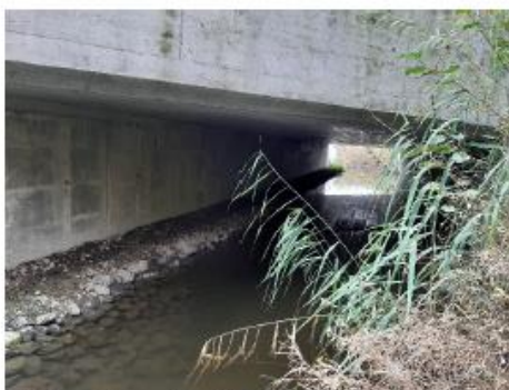
7) Gewässerdurchlass Seeligraben Rütistrasse
