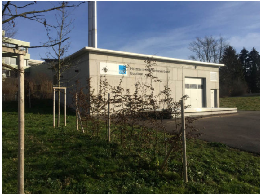
Wärmeverbund der EKZ in Bubikon
