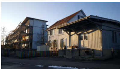
Alter Bahnhof Wolfhausen
