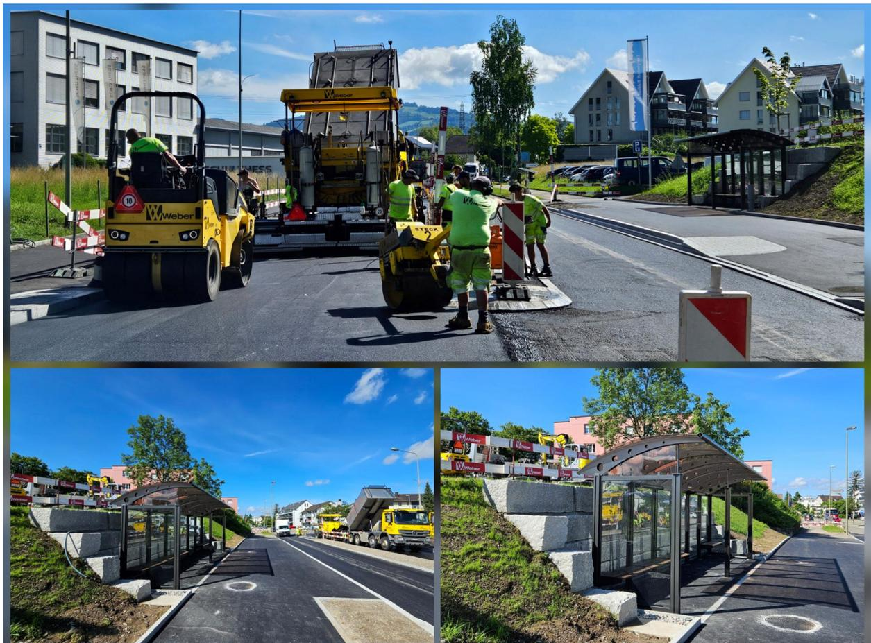
Collage Bauarbeiten Belageeinbau Landstrasse und neuer Personenunterstand in Fahrtrichtung Bubikon, Haltestelle Wolfhausen, Zentrum
